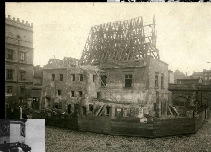
Rozbiórka Starej Wagi Miejskiej na Starym Rynku
